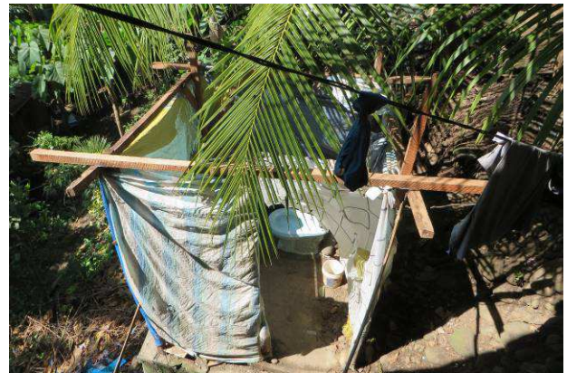
Die Toilette im Freien ist nur notdürftig durch Planen geschützt. Das „Dach“ fehlt, weil diese Plane für das Haus benötigt wurde.
